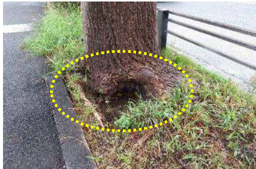
腐朽で空洞が発生、強度が低下
