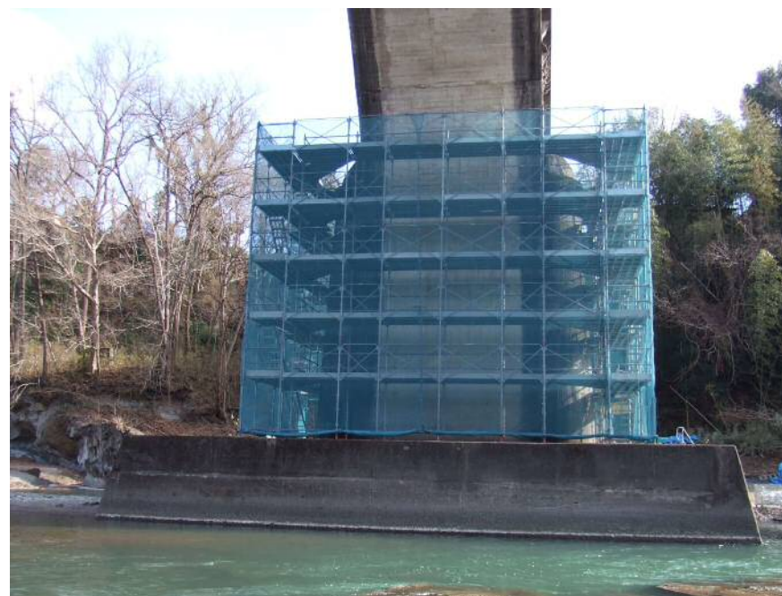
足場の設置状況
