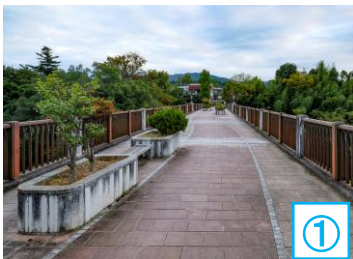
舗装を撤去して防水工事等を実施後、現状に近い見た目のブロック舗装を実施
