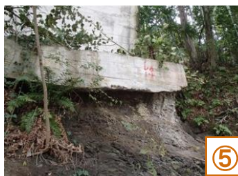
橋脚の浸食箇所が降雨等で、さらに悪化しないように、コンクリートで補強
