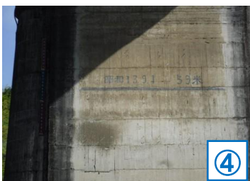
橋脚のひび割れに対して、補修材を注入
