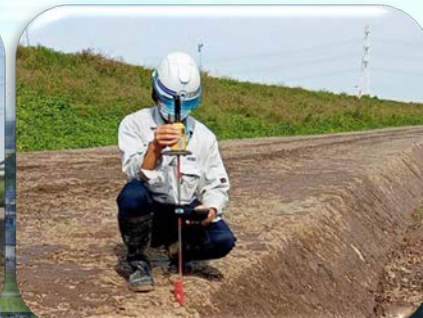
TSを用いた出来形管理
