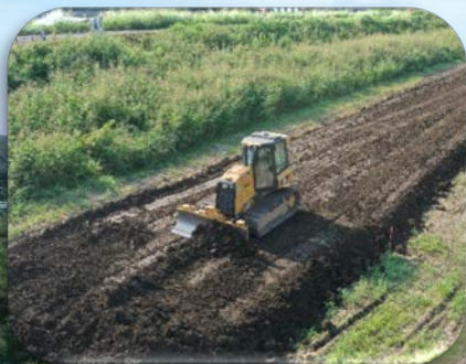
ICT建機での施工
