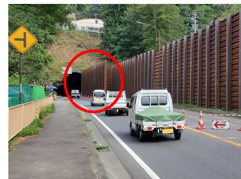
H鋼杭+横矢板撤去(今後実施)
