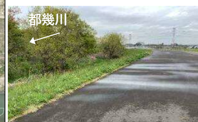
写真② 堤防天端と河畔林
