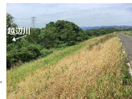
写真② 下流端より上流方向全景
