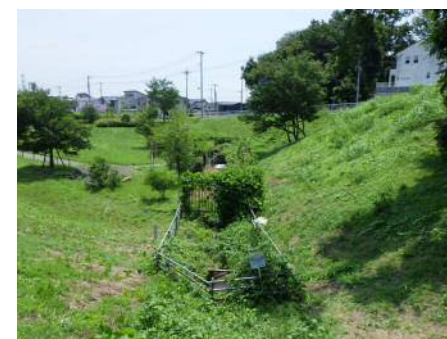
写真② 万世樋管より堤内地方向
