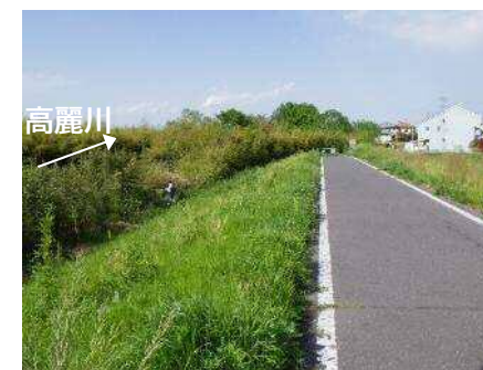
写真② 上流端より下流方向全景
