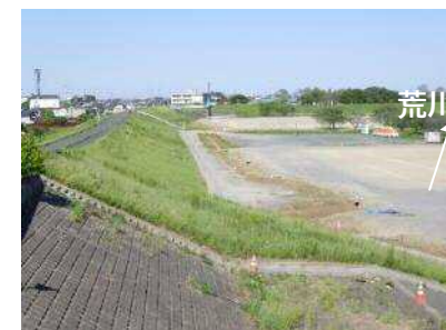
写真② 堤防の上流端より全景
