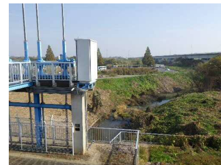
写真① 古谷樋管より入間川方向
