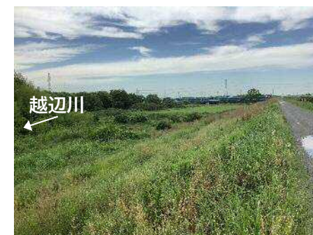
写真② 下流端より上流方向全景
