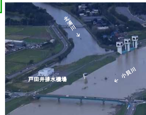
(R1.10洪水時の戸田井排水機場周辺の様子)
