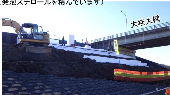
施工状況 (発泡スチロールを積んでいます)
