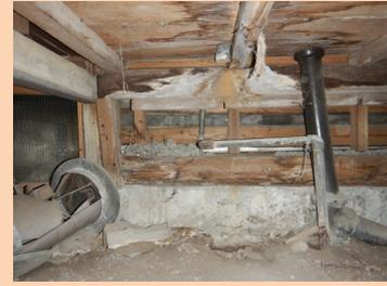
旧大隈別邸:土台の腐朽
