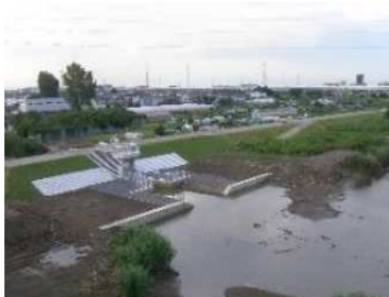
堤防整備に伴う樋管整備 (埼玉県八潮市伊勢野地区)
