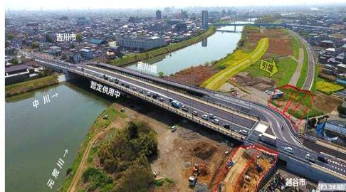
堤防整備に伴う橋梁架替(吉川橋)
