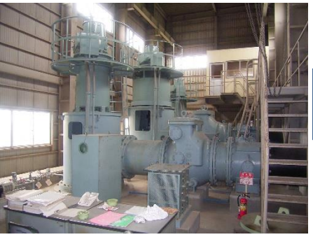
【各ポンプ毎に監視・操作】
