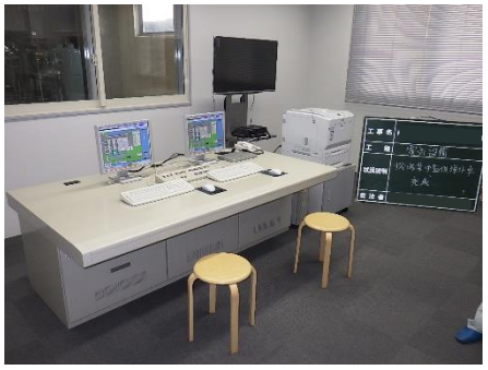
【操作室から監視操作】
