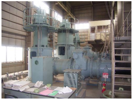
【商用電源による運転操作】
