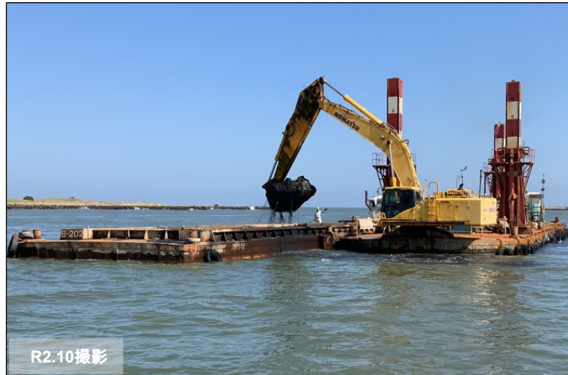
利根川下流部での対策状況
