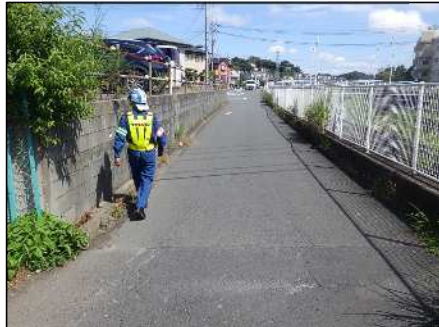
<徒歩巡回による変状監視>
