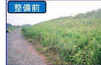
堤防の斜面が利用しにくい
