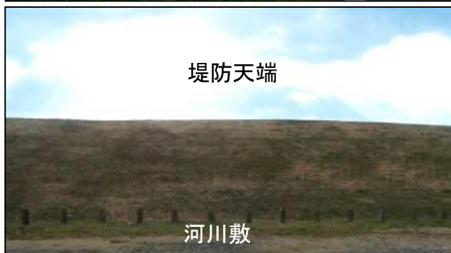
河川敷と堤防天端のアクセスが悪い
