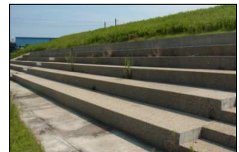
高水護岸(階段護岸)
