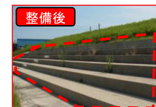
高水護岸(階段護岸)の整備を実施
