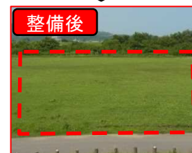
基盤整正(伐木、掘削盛土、整正)を実施
