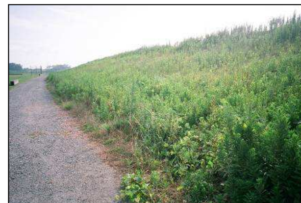
堤防の斜面が利用しにくい
