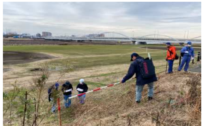
▲堤防点検：踏み荒らしの調査
