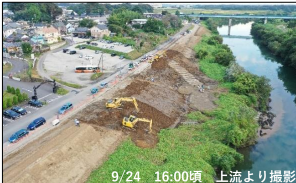
9/24 16:00頃 上流より撮影
