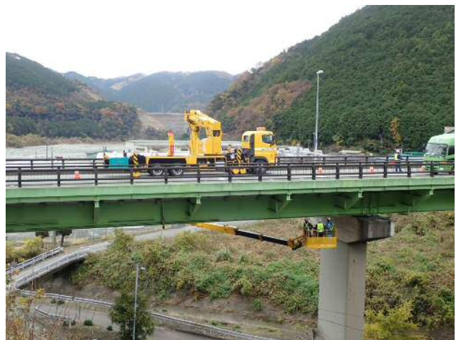
橋梁点検車による点検のイメージ写真 写真は山梨県内国道の昼間点検時の写真です。
