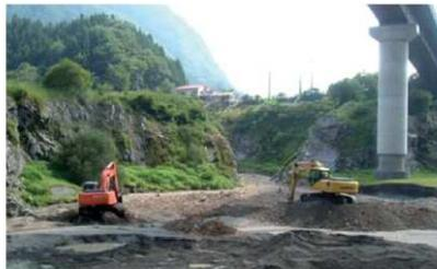
川治ダムにおける堆積土砂の掘削
