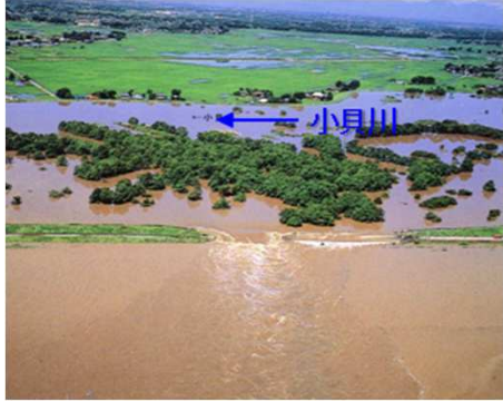
常総市本豊田 右岸35.6k堤防決壊
