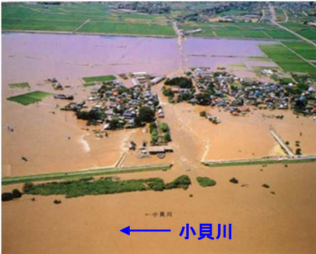
筑西市赤浜 左岸49.0k堤防決壊
