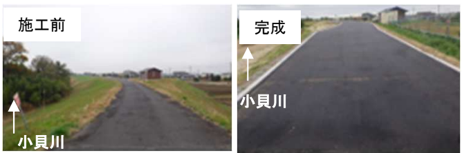
堤防の整備の実施状況 (取手市中内地先)
