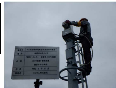
CCTVの点検状況
