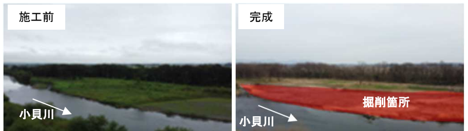
河道掘削の実施状況(下妻市高道祖地区)
