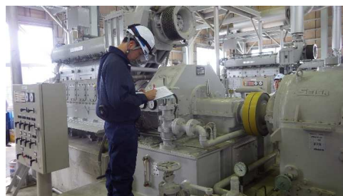
機械設備の点検状況
