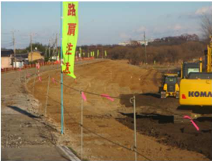
堤防の整備 堤防の整備状況（R3.3時点）
