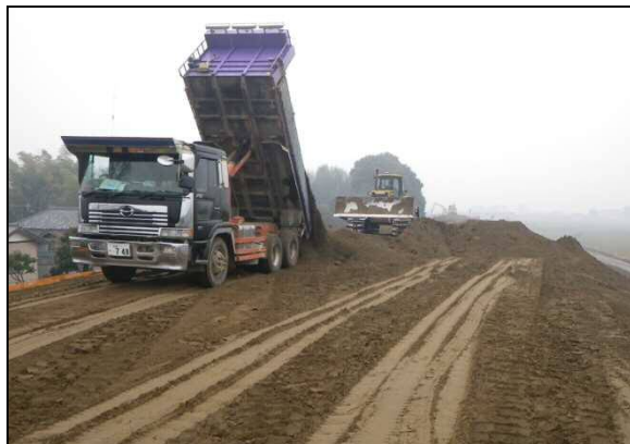
盛土材の搬入状況
