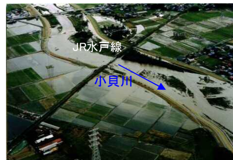
筑西市 61k付近の浸水状況
