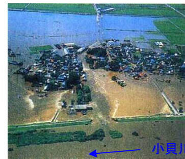
常総市本豊田 右岸 35.6k付近の状況
