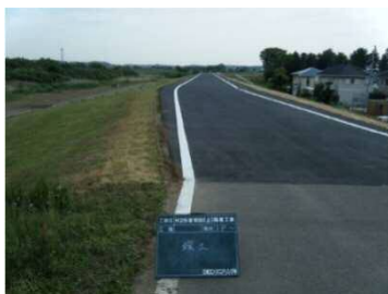
▲堤防整備の状況
