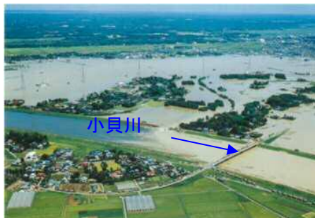
龍ヶ崎市 左岸 JR常磐線下流付近の状況
