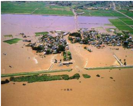
筑西市赤浜 左岸49.0k堤防決壊
