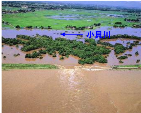
常総市本豊田 右岸35.6k堤防決壊
