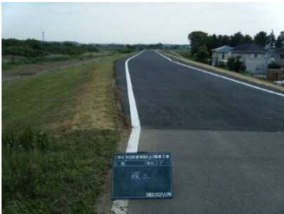
▲堤防整備の状況
