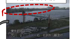
高水敷浸水前
