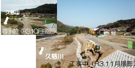
⑥R2久慈川左岸家楽地先築堤護岸外工事
