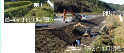
⑩R2久慈川右岸大子地先下流築堤護岸工事 (その3)工事
