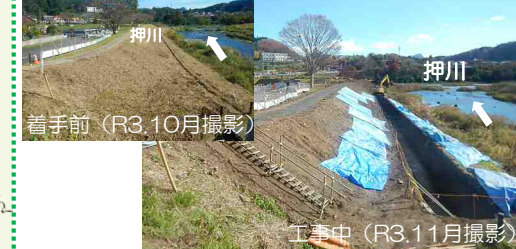
⑨R2久慈川右岸大子地先上流築堤護岸工事
