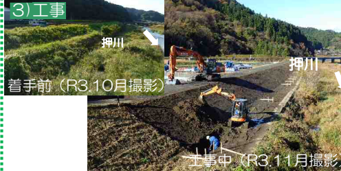
⑩R2久慈川右岸大子地先下流築堤護岸(その3)工事
