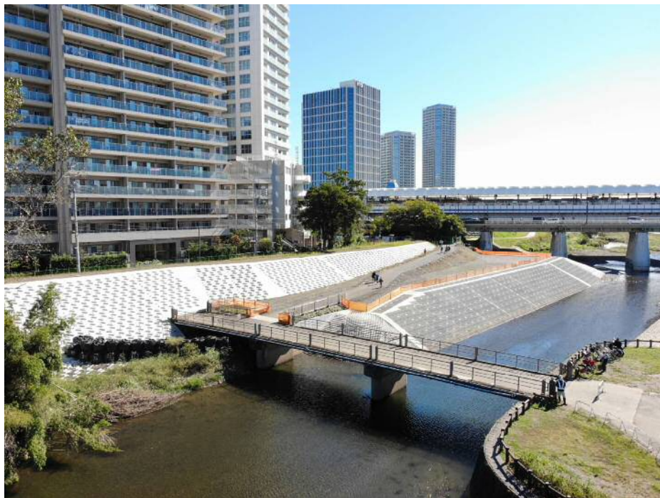
兵庫橋付近野川右岸側より
