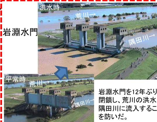
岩淵水門を12年ぶりに閉鎖し、荒川の洪水が隅田川に流入することを防いだ。
