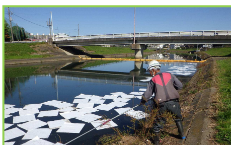
オイルマットの設置状況
