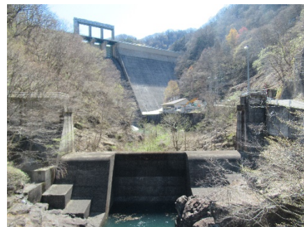
藤原ダム 令和3年4月撮影
