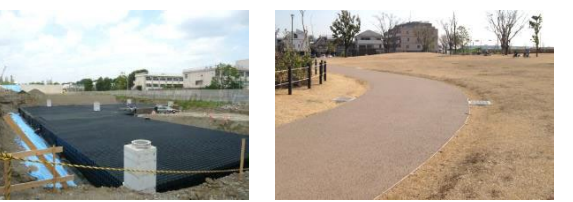
【二子玉川公園】(H25) 浸水想定区域に位置することから、プラスチック製地下貯留施設槽に加え、園路脇に緑溝や貯留機能のある植栽帯などを整備。
