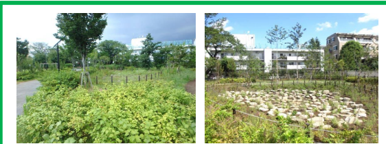
【上用賀公園】(H27) 周辺に降った水を集めて地下に浸透させる窪地状の植栽地であるレインガーデンを整備。
