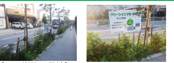
【区画街路7号線】(R元) 車道に降った雨を効率的に地中に浸透させるために排水性舗装と道路植栽帯を組合せて整備。二子玉川公園と一体となって雨水浸透機能を発揮している。
