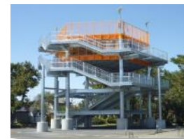
津波避難タワー
