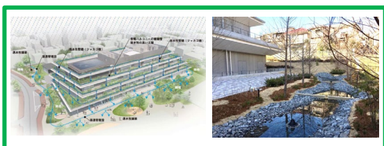
【区立保健医療福祉総合プラザ】(R2) 雨水の急激な流出を防ぐため、段丘上の建物の各階に保水性土壌や植栽などを配置するとともに、地上部にレインガーデンなどを整備。
