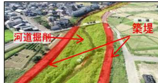
浄土川改修(河川事業(新潟県))
