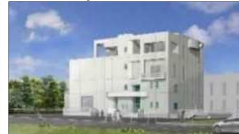
寿町排水ポンプ場整備 (下水道事業(長岡市))
