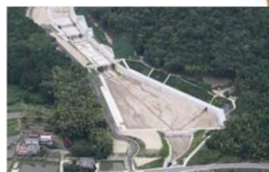
下流で砂防施設を整備
