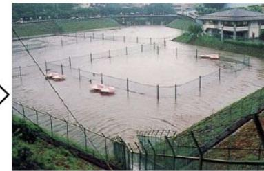
雨水貯留浸透施設の例(防災調整池)
