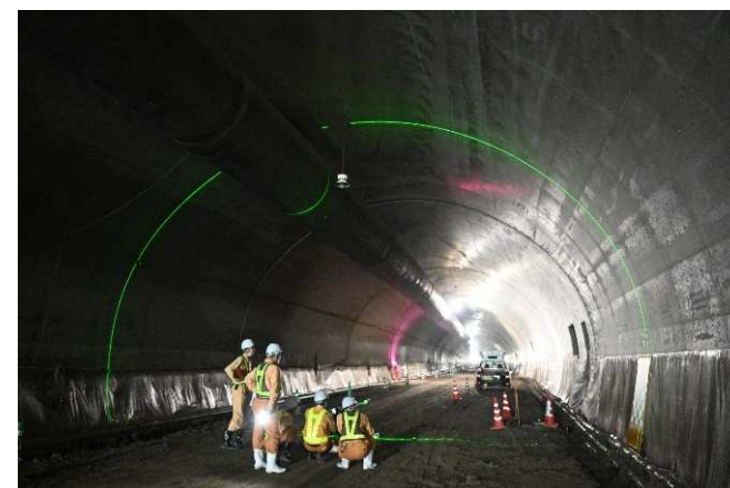
トンネル3次元計測の様子
