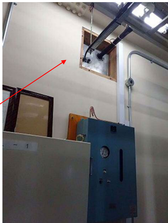
建屋ケーブル引込口
