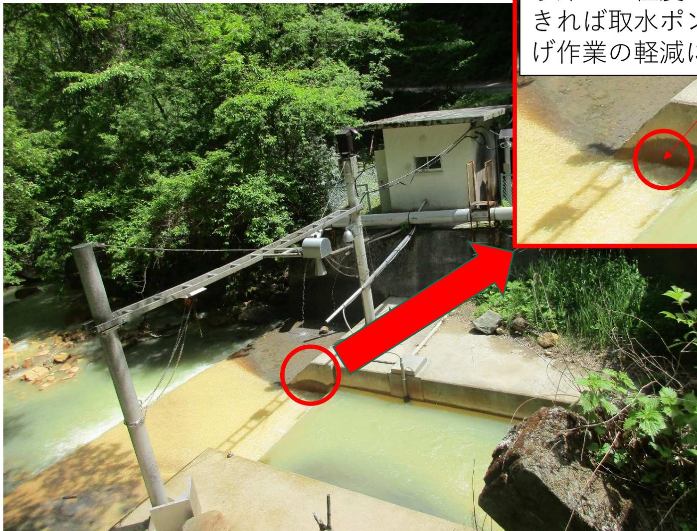
水深 5 cm 程度の流水中で pH 観測できれば取水ポンプメンテ省略、堰上げ作業の軽減に繋がる。
