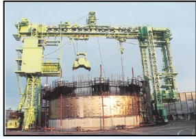
▲立坑(堅倉立坑)施工状況
