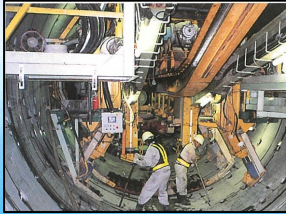
▲トンネル(第2工区)施工状況①
