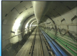
▲トンネル(第2工区)施工状況②
