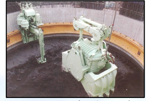
▲掘削状況(堅倉立坑)
