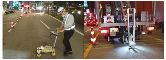
写真 1 わだち掘れ量(左)、たわみ量(右)の測定状況
