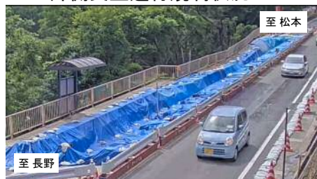
片側交互通行規制状況
