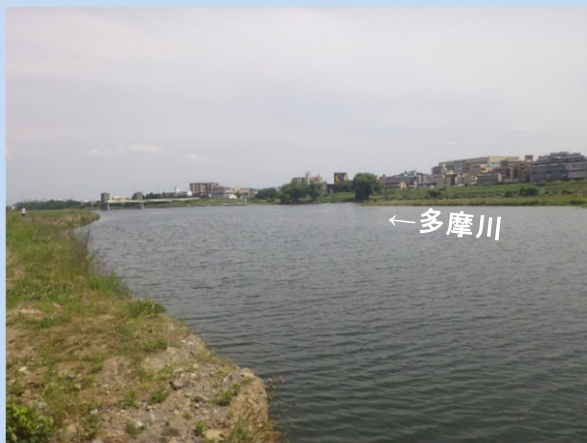
工事着手前(令和3年6月)
