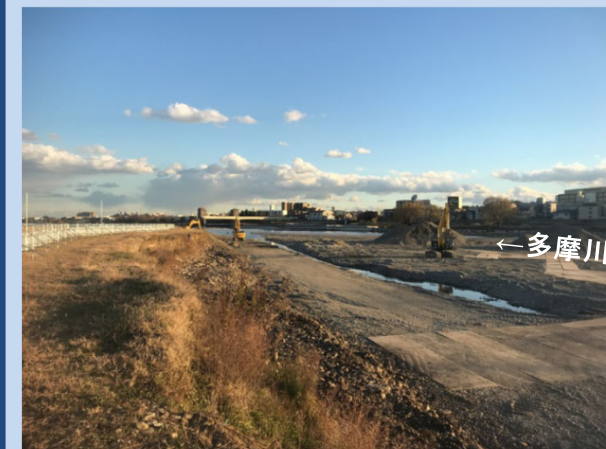
河道を掘削しています。 (令和3年12月)
