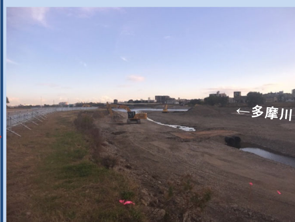
工事のため堰を下げ、水位を低下させて掘削しています。(令和3年11月)
