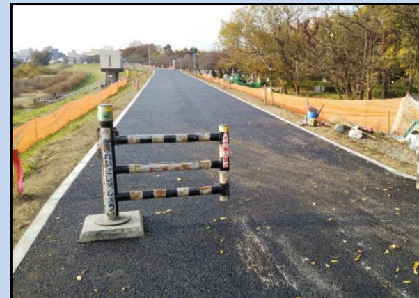
舗装完了しました。これから車止めの設置をします。 (令和3年11月)
