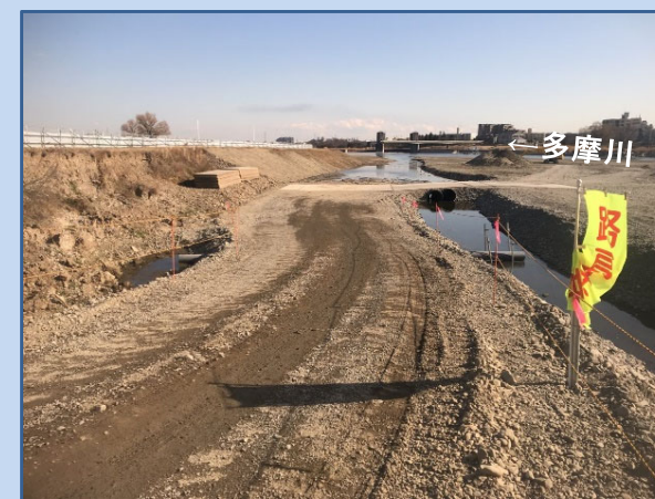
河道を掘削しています。(令和4年 1月)
