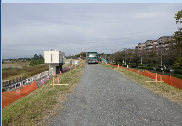
工事着手前(令和3年10月)
