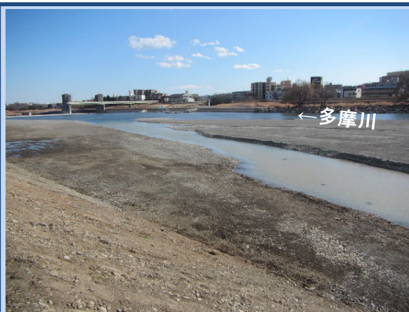
河道の掘削が完了しました (令和4年2月)
