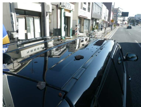
図-1 腐食金属片の落下事例
