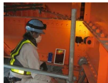
写真-2 鋼部材の中継の状況
