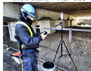
写真-3 全方位カメラによる橋梁下の中継
