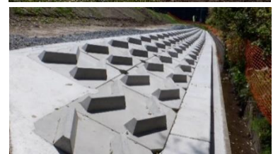
本米崎右岸(那珂市) 施工事例
