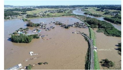
令和元年台風第19号 久慈川 松栄町
