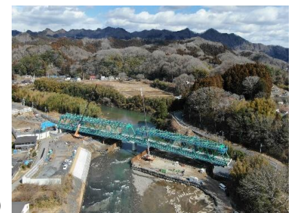
水郡線橋梁工事(2月18日撮影)
