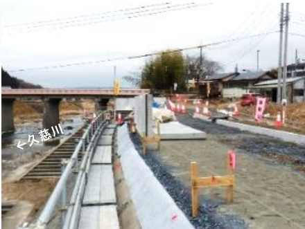
令和3年1月撮影(L型擁壁施工中)
