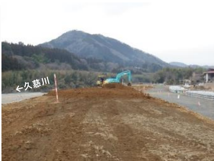
令和3年1月撮影(築堤盛土施工中)
