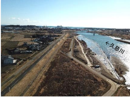
令和3年1月撮影(土砂掘削施工中)
