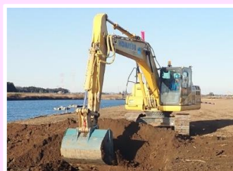
ICT建機による河道掘削
