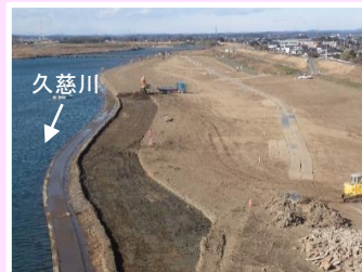
施工状況(東海村竹瓦)
