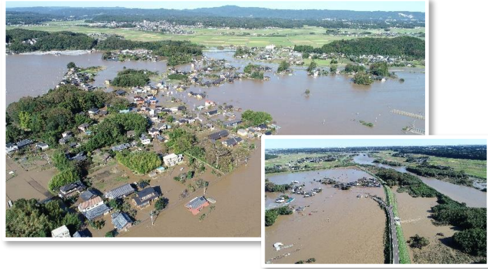
常陸太田市松栄町地先（久慈川左岸18.0k付近）
