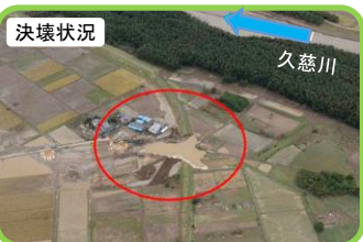
令和元年10月撮影（被災直後）
