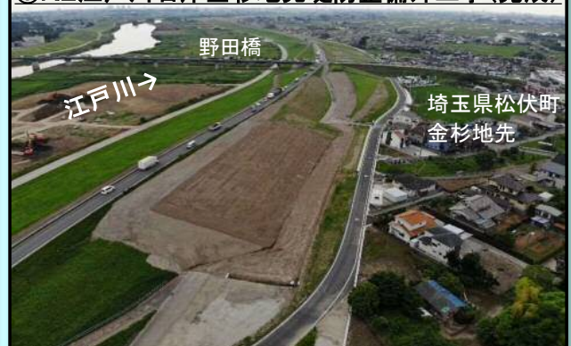
⑨R2江戸川右岸金杉地先堤防整備外工事(完成)
