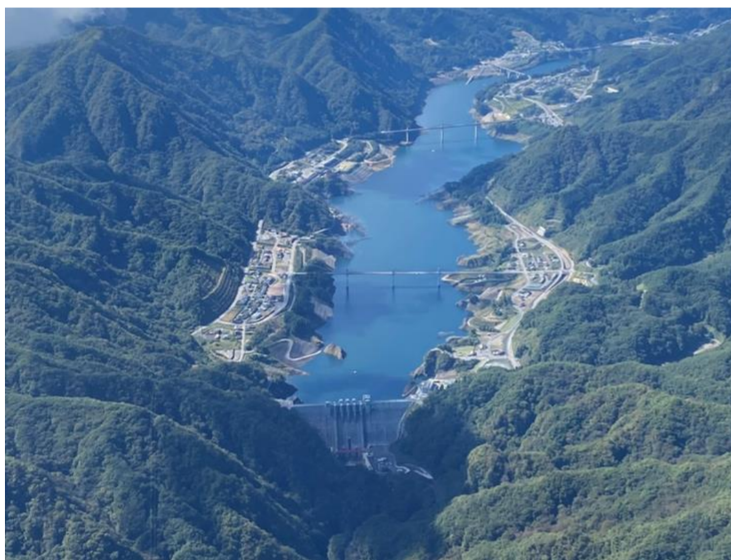
ハッ場ダム（令和３年１０月１４日撮影）
