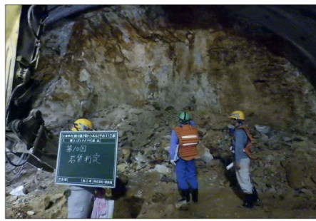
岩質判定の状況
