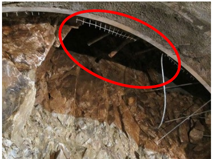
補助工法(フォアポーリング)の拔落ち
