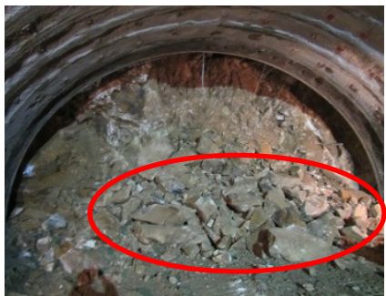
大塊の崩落が発生したため、切羽・地山の安定対策を追加
