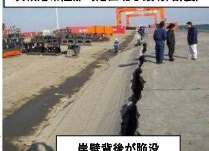
茨城港常陸那珂港区北ふ頭(非耐震)
